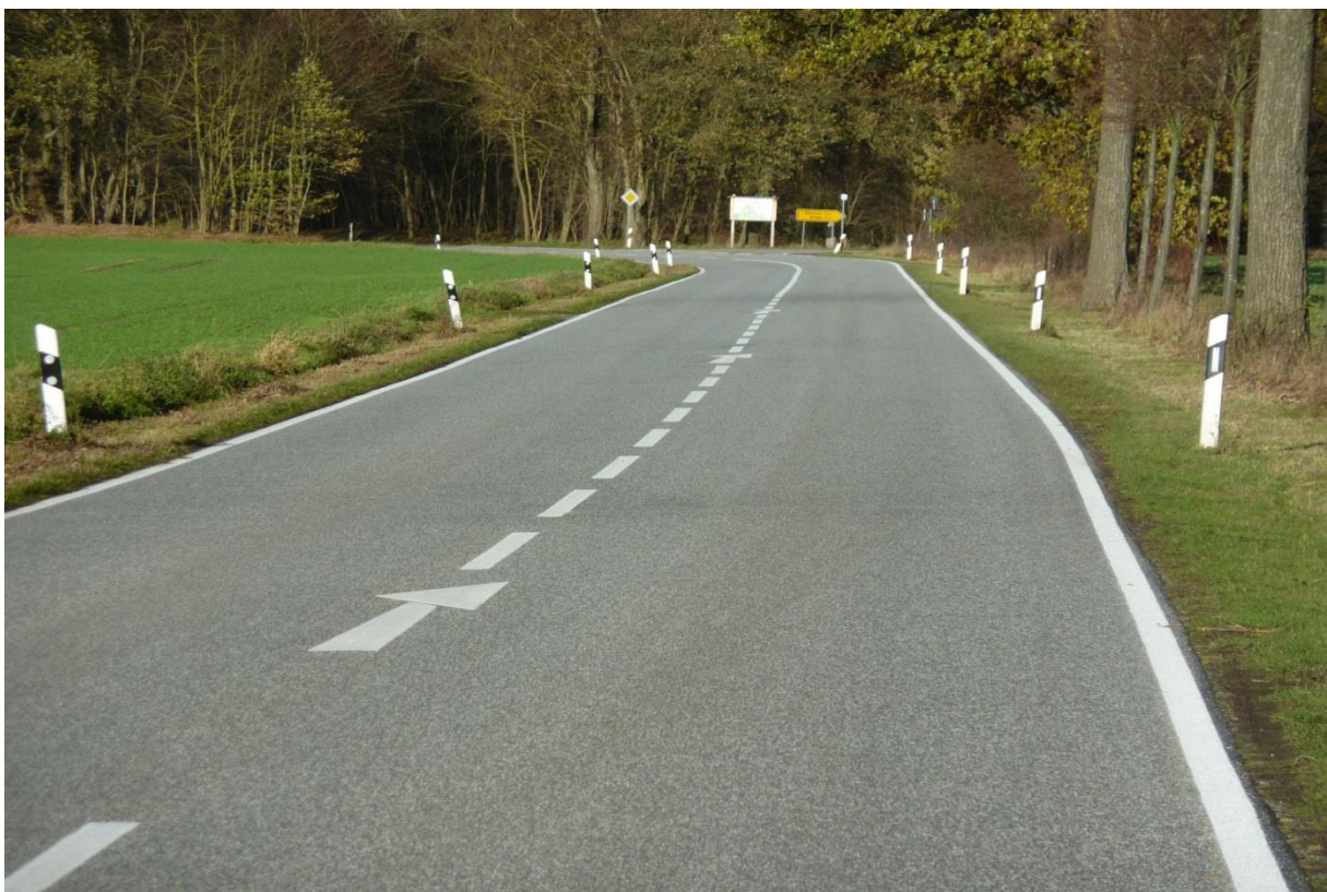
Erneuerte Fahrbahnmarkierungen auf der K 7038
