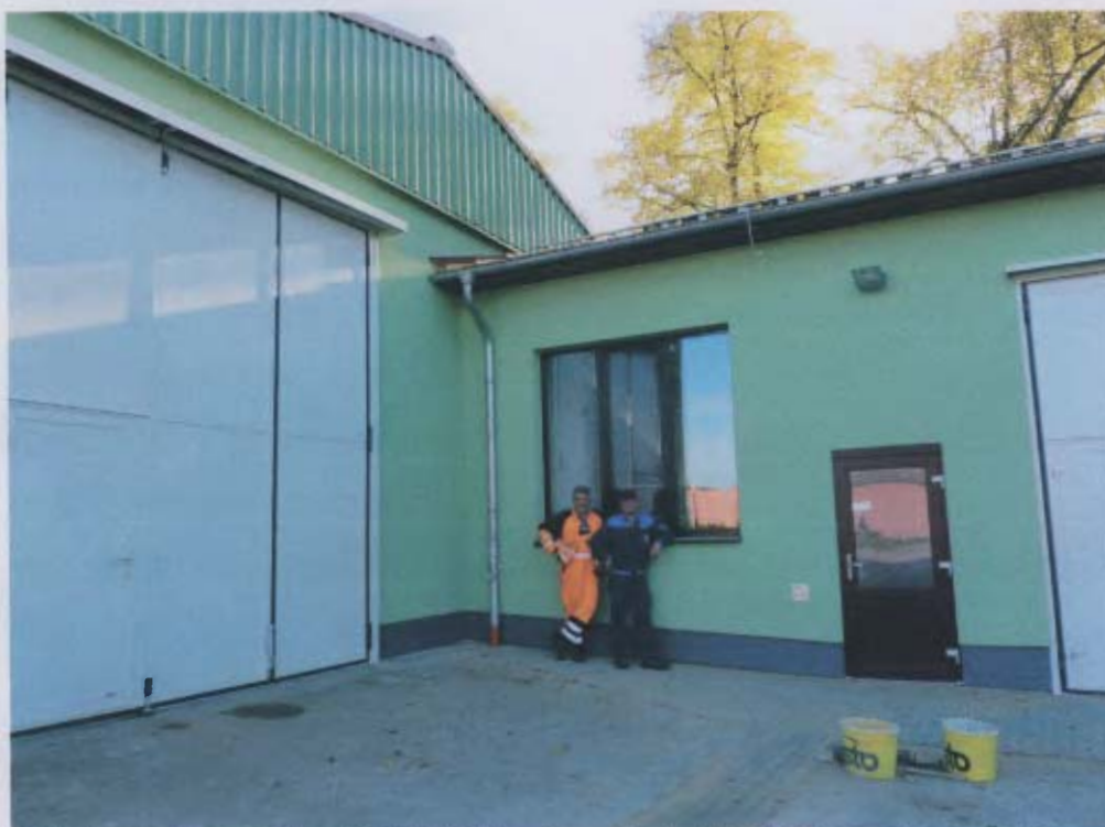
Mitarbeiter Joachim Petzold und Giesbert Krüll vor dem sanierten Werkstatt-/Lagergebäude der KSM
